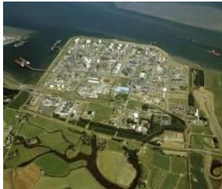
Terneuzen Site Water Reuse
